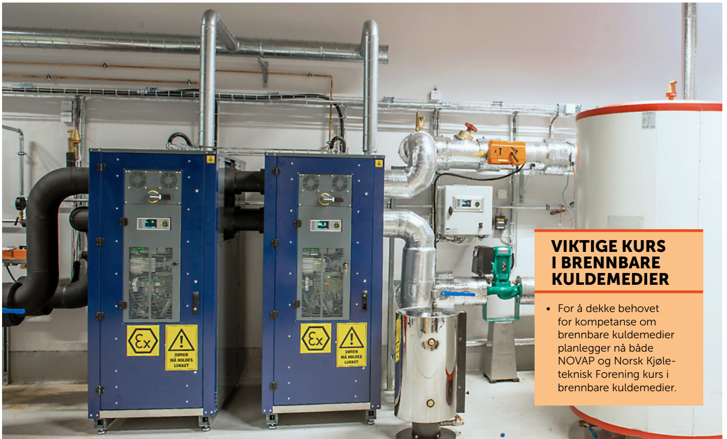
To stk ENRAD varmepumper med propan som kuldemedium i master-slaveløsning med en varmekapasitet 283 kW.
