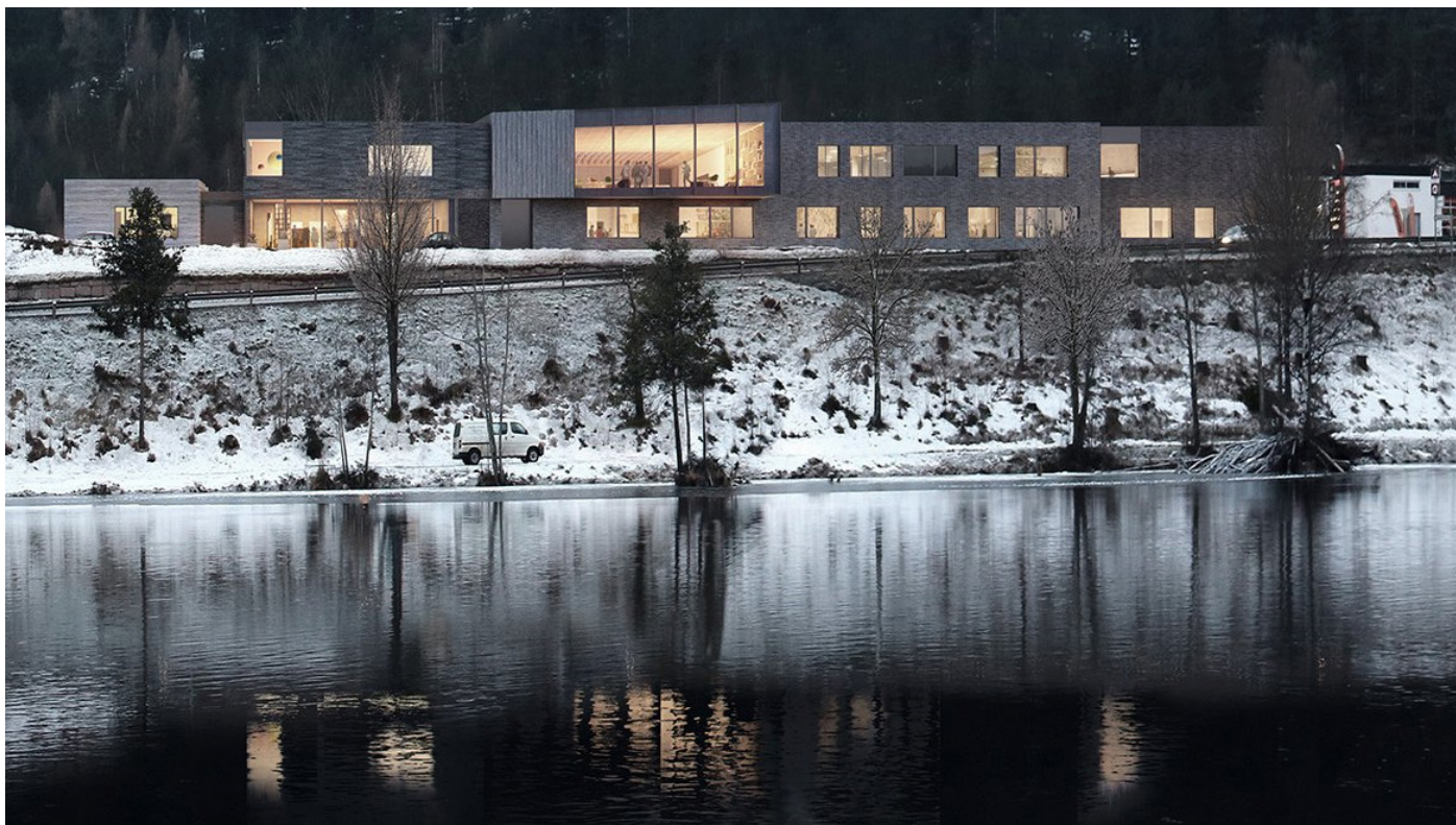
Hydrogen produsert med solvarme skal varme opp Nye Vest siden Ungdomsskole på Kongsberg om vinteren.
