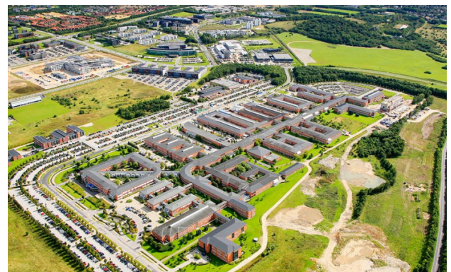
Airconditionanlægget var blevet sparet væk ved byggeriet af supersygehuset i Aarhus, og det betød op til 30 graders varme stuer flere steder.
