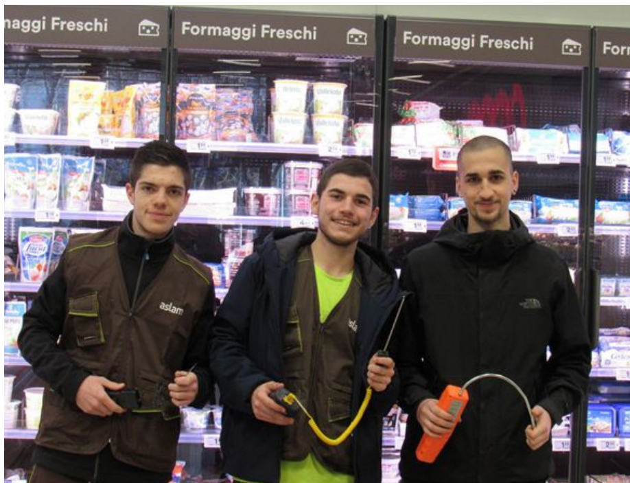
En gruppe studenter fra ASLAM i det nye laboratoriet som er en egen, liten butikk med CO 2 installasjoner.
